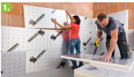
Emboîter les panneaux isolants en commençant par le sol jusqu'au plafond. Utiliser une scie égoïne pour réaliser les découpes nécessaires. Traiter la jonction entre panneaux isolants avec une bande adhésive.
