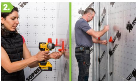
Fixer l'Appui intermédiaire de contre-cloison sur le panneau. Fixer mécaniquement les lisses hautes et basses et clipser la fourrure sur l'appui. Régler la planéité de l'ossature.
