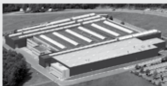
Hörmann KG Eckelhausen, Allemagne
