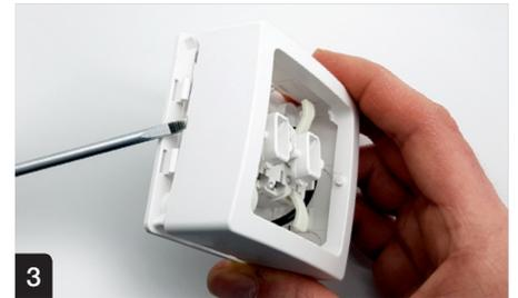
Déclipser le cadre du support à l'aide d'un tournevis
