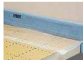
Elle doit dépasser suffisamment du nu fini de la chape raison pour laquelle nous préconisons la bande Ht=150 mm pour une dalle isolante < 8 cm et une bande Ht 200 mm au-delà.
