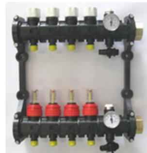
Comme l'impose le DTU, les collecteurs sont munis pour chaque circuit de deux vannes d'arrêt et d'un organe d'équilibrage. Sur l'aller, le réglage du circuit est mémorisable.
