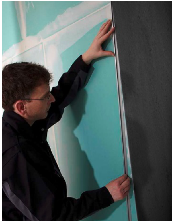
3.14 Le profilé de finition (à siliconer avec une ligne fine sur le flanc) peut être posé avant ou directement après le montage du panneau.
