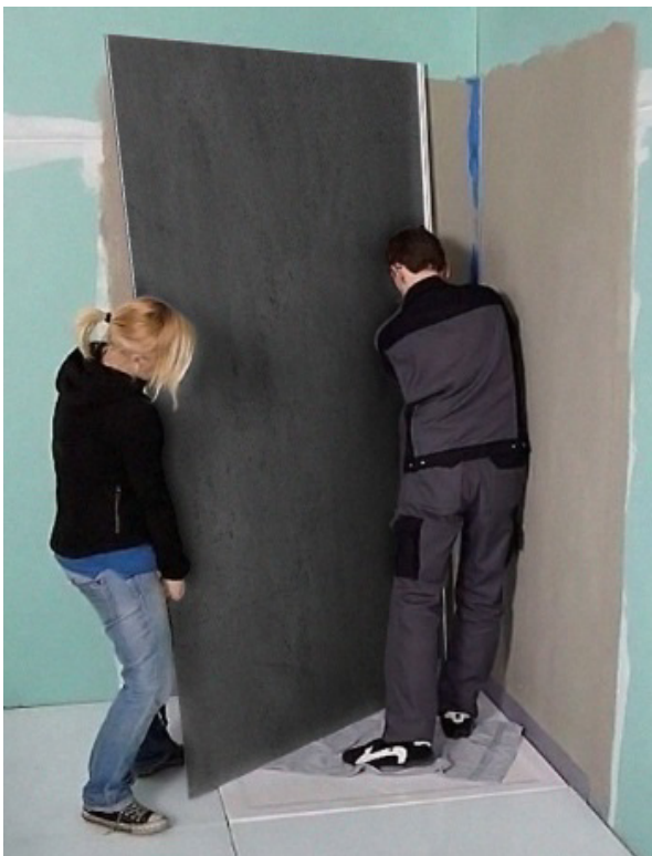
3.13 Pressez le panneau contre le mur, en commençant par l'angle.
