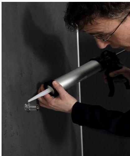
3.17 Étanchéifiez les trous de passage à l'aide de silicone réticulant pour pierres naturelles sans acide acétique.
