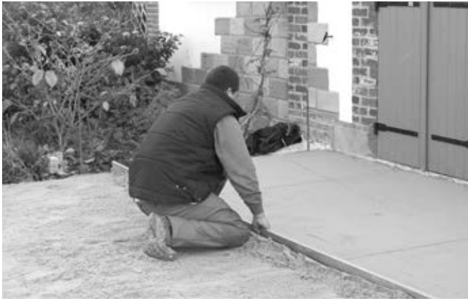
Égalisation de la couche de sable à l'aide de cales de niveau.
