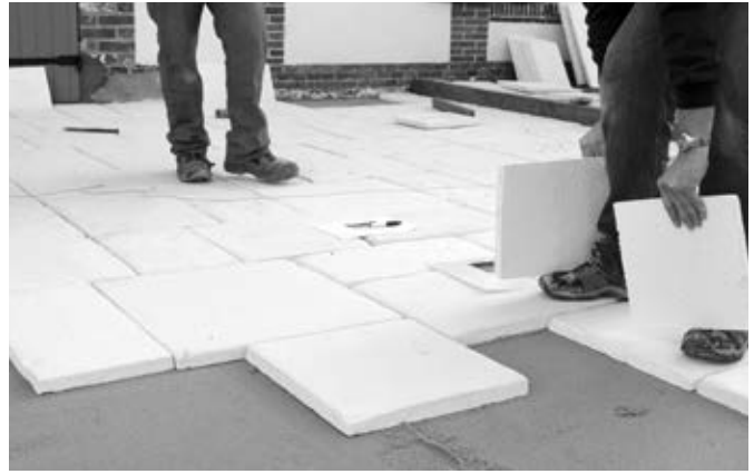
Mise en place des dallages (ici des dalles Castellane en opus multiformat) sur lit de sable parfaitement de niveau.
