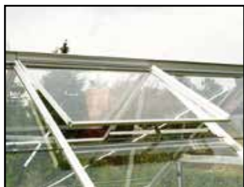
Lucarne Vue extérieure
