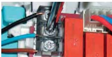
Raccorder le câble d'alimentation sans oublier la terre
