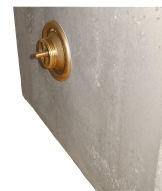
Bonde à 19 cm du mur, centrée dans le bac (21cm)
