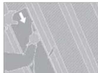
**En principe, la première couche ne comporte pas de pare-vapeur. Dans le cas contraire, lacérez le kraft au cutter pour « aérer » l'isolant.**
