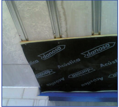
Sistema tornillo-arándela sobre maestra.
