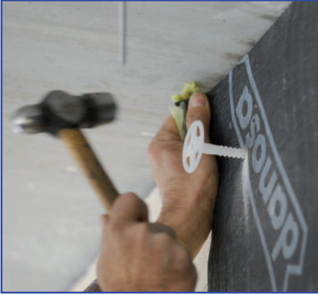
Sistema con fijaciones de PVC.
