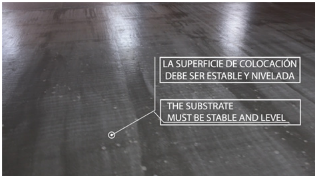
La Surface de pose doit être stable te niveau
