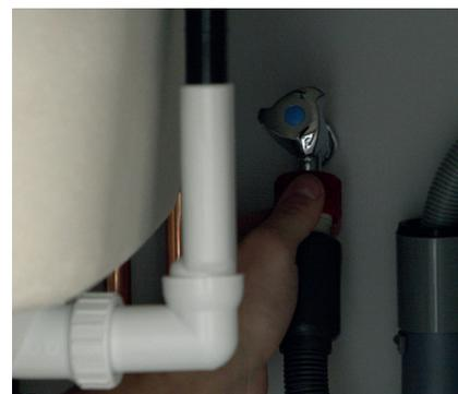
► **Pour le lave-vaisselle**, l'évacuation d'eau doit être sous l'évier et en aucun cas derrière le lave-vaisselle.
