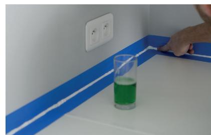
► **Lissez le joint** au doigt mouillé dans du liquide vaisselle et entendez le surplus.
