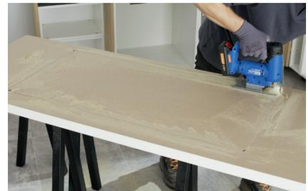
► **A l'intérieur du tracé en pointillé**, percer aux 4 angles un trou de 10 à 12 mm. Puis passer dans ces trous, la scie sauteuse et découpez.
