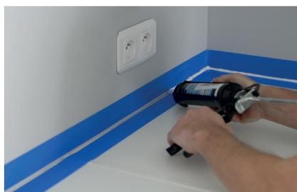
► **Protégez le plan de travail** et le mur avec un ruban de masquage. Puis déposez le joint de silicone à la jonction entre le plan de travail et le mur.
