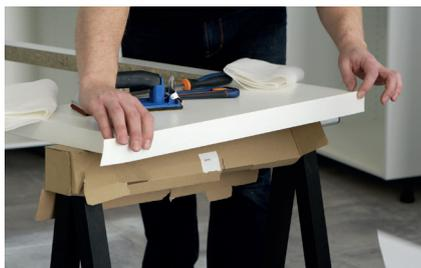
► **Choisissez une bande de chant** d'une largeur supérieure à celle du chant à couvrir et dépassant de 3 cm de chaque côté en longueur.
