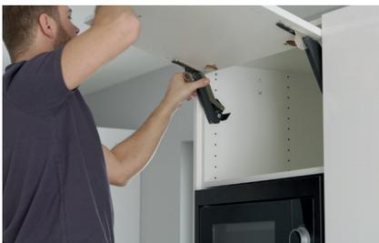
► **Clipsez** la façade sur le mécanisme.
