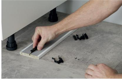
► **Positionnez la plinthe au sol,** le joint vers le bas, insérez les fixations dans fente interne de la plinthe en face des pieds de votre meuble.
