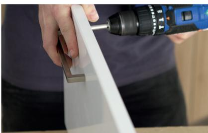
► **Avec des vis adaptées** à l'épaisseur de la porte, on fixe les poignées par l'intérieur.
