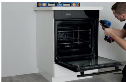
► **Coupez le courant** et réalisez les branchements électriques. Faites appel à un professionnel si nécessaire. Glissez le four puis vérifiez que le four s'ouvre correctement. Fixez le four au meuble selon les indications du fabricant.
