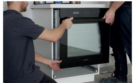
► **Glissez le four sur les équerres** pour tester que le four passe en hauteur. S'il est trop haut, mesurez la côte supérieure pour redescendre d'autant les équerres et vissez-les.
