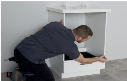
► **Pour une aération efficace** le meuble doit être découpé et être fixé au mur. Repérer à quelle hauteur vous voulez fixer le four. Ici, on place le tiroir en bas du meuble, on trace un repère au-dessus de la façade et un décalage de 8 mm.
