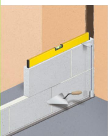
Posiziona il blocco e controlla con la livella e il filo a piombo la **perfetta planarità**. Procedi con i blocchi successivi, stendendo il collante solo sul lato verticale del blocco già fissato. Elimina l'eccesso di collante con la cazzuola.
