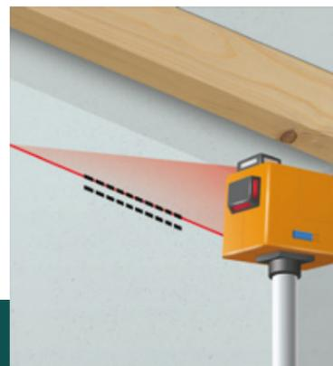
Sistema la livella laser al centro della stanza e proietta il raggio nel punto esatto in cui hai tracciato il **segno di riferimento** per i montanti.
