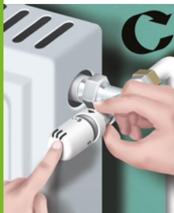
Con una mano, spingi la testa verso la valvola: con l'altra, chiudi l'anello che garantisce il fissaggio. In alcuni modelli il fissaggio avviene semplicemente a scatto.
