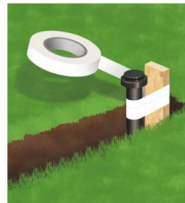
Inserisci nel terreno il paletto che farà da supporto all'irrigatore. Fissa l'irrigatore al paletto con il **nastro adesivo**.
