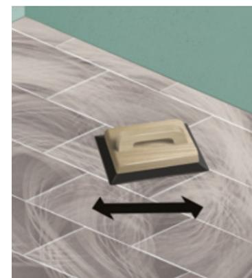
Stendi lo stucco su una superficie pari a 2 m<sup>2</sup>, aiutandoti con il frattone in gomma. Passa il frattone **in diagonale** per rimuovere l'eccedenza ed evitare di incidere lo stucco.
