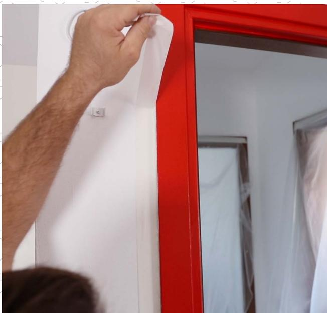
**Rimuovi il nastro** per mascheratura senza attendere l'asciugatura dello smalto.
