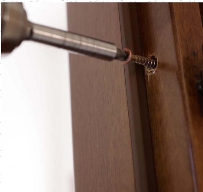
Rimuovi le viti di fissaggio nel telaio (se presenti).
