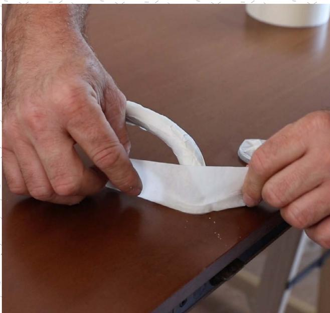
**Copri con il nastro per mascheratura** la placca della serratura e la maniglia.
