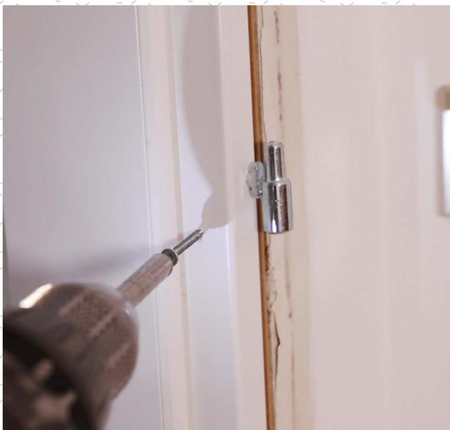
**Fissa il telaio** al muro con le viti.
