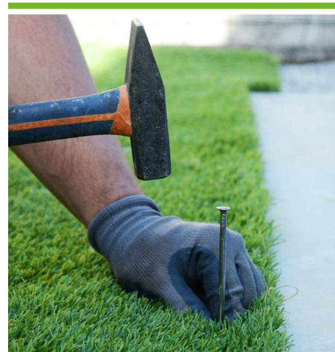
**Posa il primo telo di erba sintetica:** per la direzione di posa, considera che la parte in contropelo è la migliore da vedere. Posizionalo con attenzione lungo il perimetro del prato, intorno ad ogni ostacolo o elemento architettonico. **Lascia sempre un paio di mm in più,** per farlo leggermente sbordare ed essere certo di ottenere una copertura perfetta.
