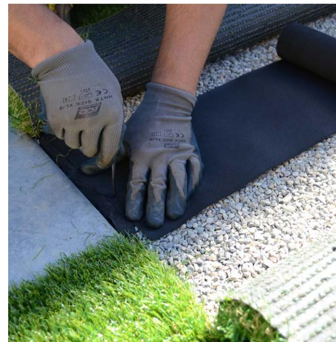
Apri i teli a libro e **posiziona sotto le giunture il nastro tessile per l'incollatura**, in modo che sia centrale rispetto ai due teli. Fissalo alle estremità e al centro.
