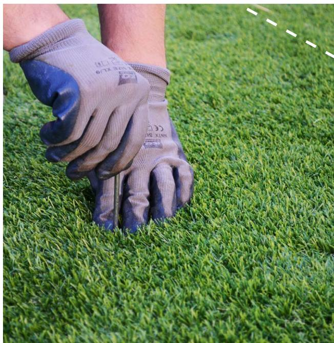
Prima di incollare i teli, **inserisci dei chiodi a 50 cm dalle giunture**, per fissare temporaneamente il manto e fare in modo che non si sposti durante l'incollatura.
