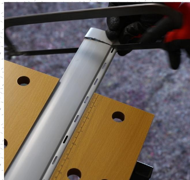
Taglia a misura la tapparella: se hai acquistato un kit di aste, devi rifilarle una a una. Esegui il taglio con il seghetto. Per lavorare in sicurezza, indossa i guanti e posizionati su un banco di lavoro o un piano stabile. Per un lavoro più accurato, conviene utilizzare un seghetto alternativo.
