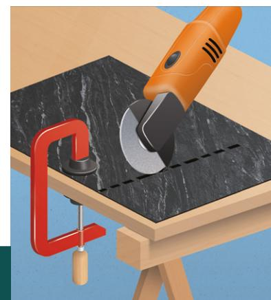
Traccia la linea di taglio con la matita e taglia le lastre con la smerigliatrice. Disponi **il lato tagliato verso uno spigolo interno**, o il pavimento, in modo che sia il meno visibile possibile.
