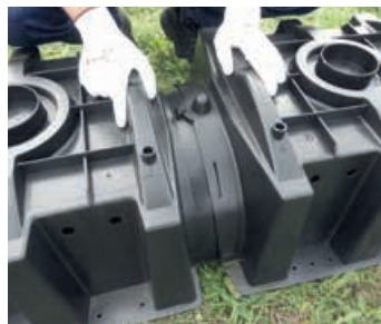
6. Podczas układania tuneli sprawdzić połączenie między nimi.
