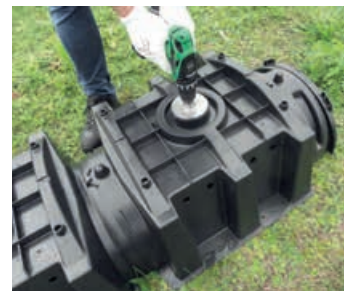
8. W ostatnim tunelu każdej nitki należy wyciąć zaślepiiony otwór przy użyciu otwornicy.
