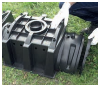
7. Ostatni tunel zakończyć dekle. Po ułożeniu całej nitki tuneli należy zamocować zaślepki, które dołączone są do zestawu.
