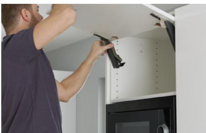
► **Clipsez** la façade sur le mécanisme.
