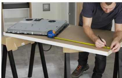
► **Selon la notice de la plaque de cuisson**, contrôler les dimensions de la découpe d'encastrement et son emplacement grâce au contour intérieur déjà dessiné sur le plan de travail.
