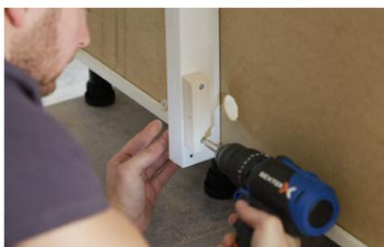
► **Pour préparer la mise en place** de la joue arrière de l'îlot, dans chaque angle en bas, percer puis dans l'alignement des trous, fixer des tasseaux de bois sur l'arrière de vos meubles.
