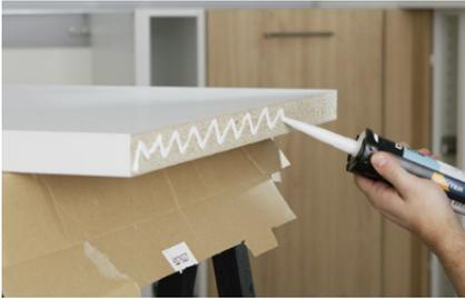
► **Déposez du mastic** silicone sur le chant.
