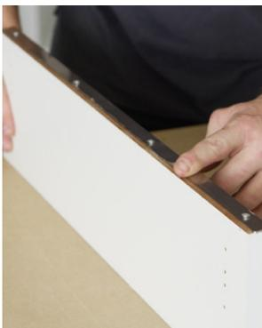
► **Placez ensuite la cornière** en aluminium orientée vers le bas et vissez-la. Dernière étape : lissez le joint au doigt mouillé dans du liquide vaisselle pour une finition parfaite.
