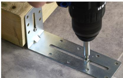
► **Assemblez les supports de fixations,** puis fixez-les au sol avec des visseries adaptées à la nature du sol.
