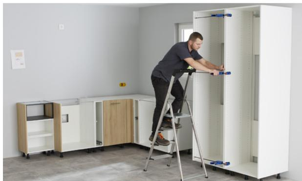
► **Sous contrôle d'un niveau à bulle**, ajuster la hauteur des meubles en réglant les pieds. Repérez puis réalisez les étapes de fixation des meubles au mur, puis entre eux.
