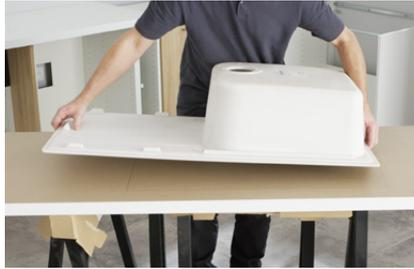
► **Positionnez la cuve de l'évier** à l'intérieur du contour et mettez à fleur du tracé de l'avant du plan de travail. Tracez l'emplacement de l'évier.
