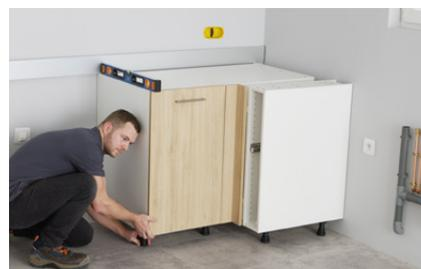
► **Sous contrôle d'un niveau à bulle** Ajustez la hauteur des meubles en réglant les pieds.
