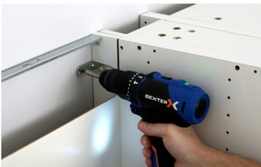
► **Pour éviter tout risque de basculement**, les meubles doivent être solidement fixés au mur. Vérifier la pertinence et la solidité du mur afin de s'assurer que le mur puisse supporter la charge du meuble/de l'objet et résister aux forces générées au niveau des fixations. Prévoir des vis chevilles adaptées au type de matériau de votre mur. Celles-ci ne sont pas incluses. Pour obtenir des conseils sur les vis et ferrures adaptées à votre mur, adressez-vous à un vendeur spécialisé.
