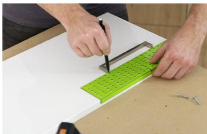
► **Mesurez la position** de la poignée depuis le bas de la porte. Puis, à l'aide du gabarit de perçage pour poignée, on pointe avec précision l'emplacement des extrémités de la poignée.
