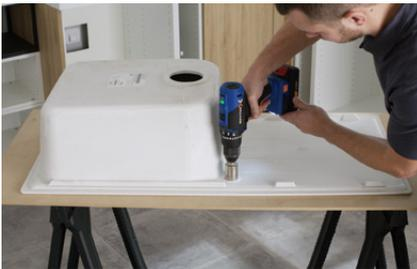
► **Percez le trou** du robinet à l'aide d'une scie cloche diamant (diamètre 35 mm).
