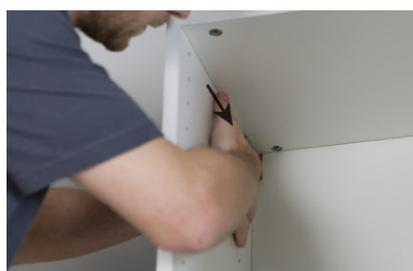
► **Déplacez le système** anti-bascule en direction du mur
