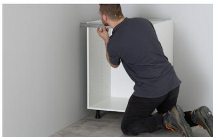
► **Le fileur permet de combler un espace vide** dans le coin de la pièce. Et permettre d'ouvrir plus facilement les portes des meubles côté mur. Le fileur est assorti à vos façades. Mesurer l'écart entre le mur et le meuble.
