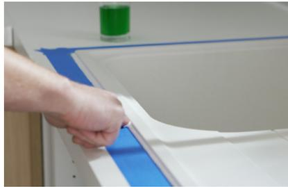
► **Lissez le joint au doigt mouillé** dans du liquide vaisselle et enlevez le surplus de silicone.
