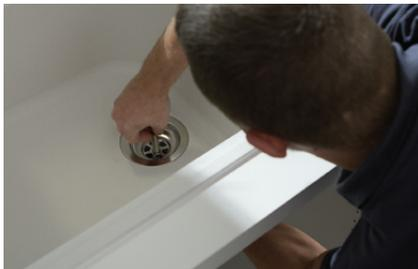
► **Commencez par couper l'eau !** Vous pouvez ensuite faire appel à un plombier professionnel pour réaliser les branchements ou réaliser les travaux vous-même en raccordant les flexibles, puis la sortie du siphon au tuyau d'évacuation des eaux usées.
