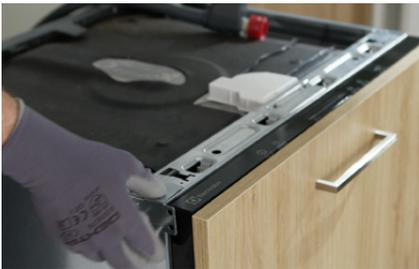
▶ **Selon les modèles**, mettre en place des équerres anti-basculement.
