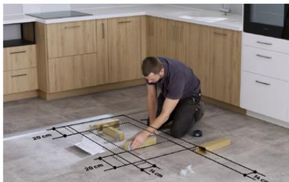
► **Pour déterminer le bon emplacement,** assurez-vous que vous disposerez d'un espace suffisant et confortable pour circuler tout autour. Puis, tracez l'emplacement extérieur et intérieur de votre îlot, selon la notice des supports de fixations.
