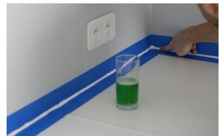
► **Lissez le joint** au doigt mouillé dans du liquide vaisselle et entendez le surplus.
