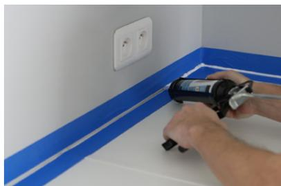
► **Protégez le plan de travail** et le mur avec un ruban de masquage. Puis déposez le joint de silicone à la jonction entre le plan de travail et le mur.
