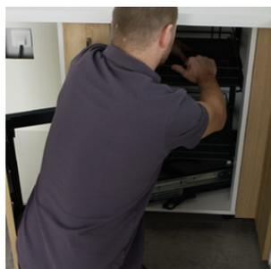
► **Dans cette autre modèle**, stabiliser les paniers avec les éléments de fixation.
