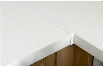
► **Déposez du mastic sur le chant** de l'autre plan. Positionnez le plan de travail sur les meubles. Pressez le côté encollé contre le profil de jonction.
