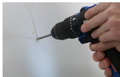
► **Retirez la structure** et percez selon les diamètres de fixations adaptées à votre mur.
