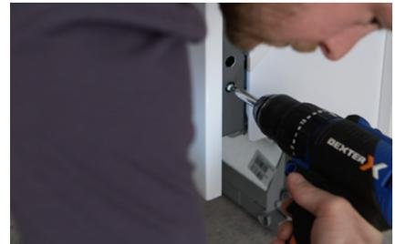
► **Puis faites les derniers vissages** en suivant les recommandation du fabricant de l'électroménager.
