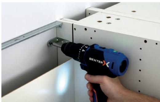
► **Per evitare il rischio di ribaltamento**, i mobili devono essere saldamente fissati alla parete. Verificare l'idoneità e la resistenza della parete per assicurarsi che questa possa sostenere il carico del mobile/oggetto e sopportare le forze generate dai fissaggi.
