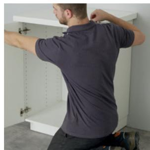
▶ **Hanno** la particolarità di avere i fori della cerniera da entrambi i lati per consentire di scegliere il senso di apertura del mobile.
