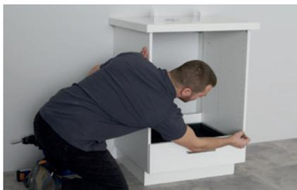
► **Per una ventilazione efficace**, lo schienale deve essere tagliato. Inoltre, la base deve essere fissata alla parete. Stabilire l'altezza a cui si vuole montare il forno. In questo caso, il cassetto viene posizionato nella parte inferiore del mobile, viene fatto un segno sopra il frontale e viene effettuato uno scostamento di 8 mm.
