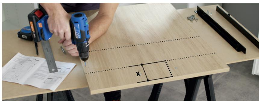
► **Trasferite poi il valore X** sulla parte superiore del frontale. Poi, sotto questo spazio X, utilizzare la sagoma dell'apparecchiatura o riportare le dimensioni della lavastoviglie sul pannello frontale.
