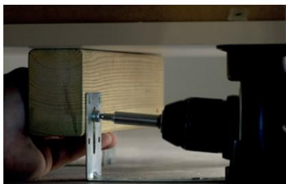
► **Poi tornate sotto l'isola.** Rimontare i listelli di legno che si incontrano con la parte inferiore del mobile. Serrare la vite sulla staffa per stabilizzare il listello.
