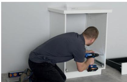
► **Fissare le staffe sotto il forno**, controllando i livelli.
