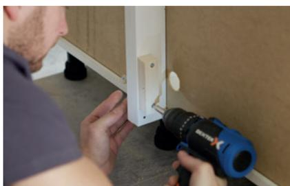
► **Per preparare la posa dello schienale retro-isola**, in ogni angolo in basso, forare sull'allineamento dei fori, fissare dei listelli di legno sul retro dei mobili.
