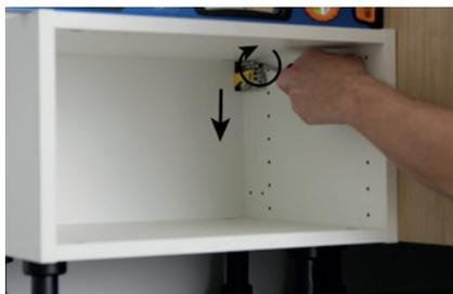
▶ **Infine, per evitare qualsiasi rischio di caduta**, stringere i ganci a muro: La vite superiore consente di regolare l'altezza del mobile.
