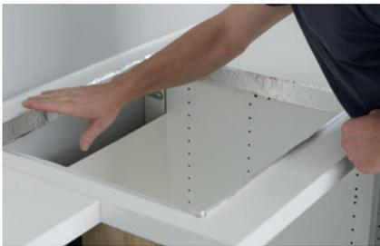
▶ **Applicare** un pezzo di nastro di alluminio lungo il bordo del foro per proteggerlo da perdite di liquidi e vapore che potrebbero danneggiarlo.
