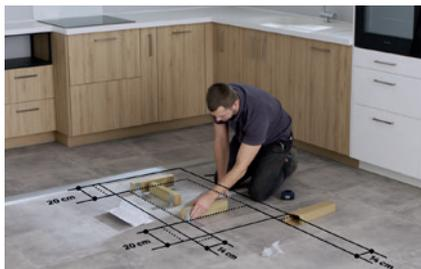
► **Per determinare la posizione giusta dell'isola**, assicurarsi di avere spazio sufficiente per muoversi comodamente. Segnare poi le posizioni esterne e interne dell'isola, secondo le istruzioni per il fissaggio dei supporti di montaggio.
