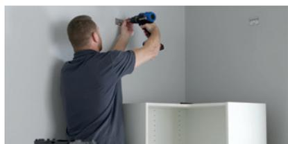
► **Forare e avvitare** le staffe di fissaggio fornite, con i fissaggi adatti alla parete.
