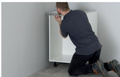
► **La fascia di tamponamento permette** di riempire uno spazio vuoto nell'angolo della stanza: E facilitare anche l'apertura delle ante dei mobili lato parete. La fascia di tamponamento si abbina ai vostri frontali. Misurare la distanza tra la parete e il mobile.
