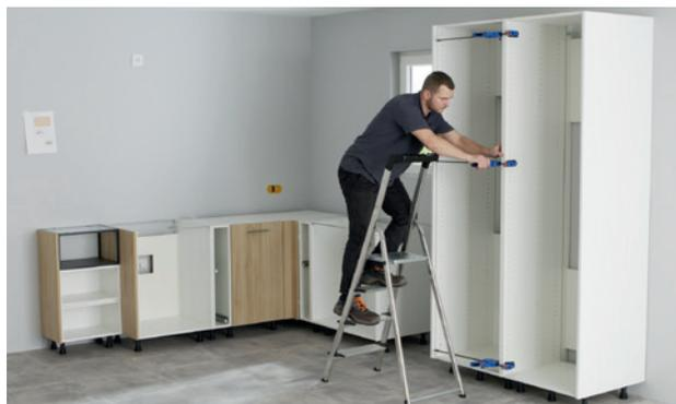
► **Sotto il controllo di una livella a bolla d'aria**, regolare l'altezza del mobile regolando i piedi. Individuare e realizzare le tappe del fissaggio dei mobili al muro, poi l'uno all'altro.
