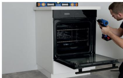
► **Staccare la corrente** ed eseguire i collegamenti elettrici. Se necessario, rivolgetevi ad un professionista. Fate scorrere il forno sulle staffe e verificare che il forno si apra correttamente. Fissare il forno al mobile seguendo le istruzioni del fabbricante.
