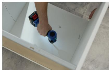
► **Infine, finire di fissare l'isola al pavimento all'interno del mobile.** Riportare la posizione del listello e avvitare il mobile. Ripetere quindi l'operazione sulle altre basi.
