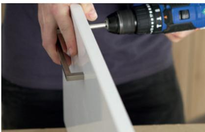
► **Le maniglie** vengono fissate dall'interno con viti adatte allo spessore dell'anta.
