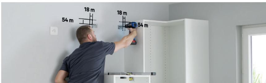
► **Ripetere lo stesso metodo utilizzato** per il primo mobile ad angolo. Se il mobile è dotato di illuminazione, ricordarsi di spegnere l'interruttore salvavita prima di effettuare i collegamenti elettrici.
