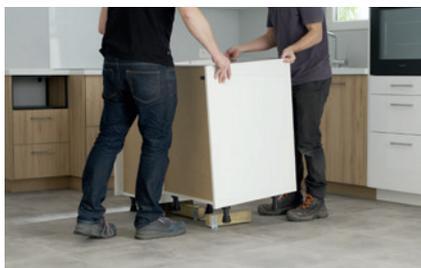
► **Posizionare i mobili e avvitateli assieme.** Controllare il livello generale dell'isola e, se necessario, regolare i piedi dei mobili.
