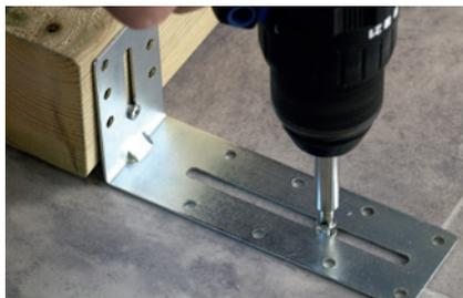
► **Assemblare i supporti di fissaggio** e fissarli al pavimento con viti adatte al tipo di pavimento..
