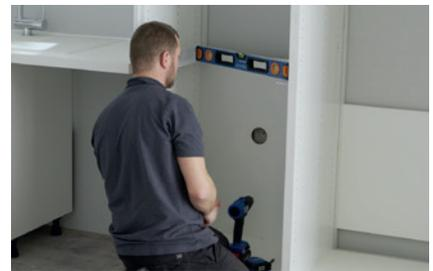
► **Fissare le staffe** che sosterranno il forno regolandone l'orizzontalità e l'allineamento con la livella.
