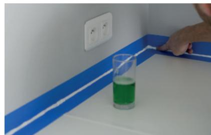
► **Lisciare la giunzione** con un dito intinto nel detersivo per piatti e rimuovere l'eccesso.
