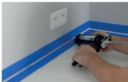
► **Proteggere il piano di lavoro** e la parete con nastro di mascheratura. Infine applicare la guarnizione in silicone alla giunzione tra il piano di lavoro e la parete.
