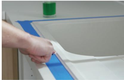
► **Lisciare la giuntura** con un dito intinto nel detersivo per piatti e rimuovere l'eccesso di silicone.
