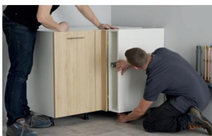
► **Sul mobile adiacente**, fissare le staffe sul lato da fissare. Posizionare il mobile accanto al mobile ad angolo, mantenendo uno spazio tra i due, servendosi della finitura angolare.
