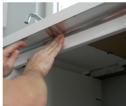
► **Applicare la barriera** al vapore fornita con l'apparecchiatura, come da immagine, per proteggere il piano di lavoro dalla condensa.
