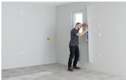
▶ **Questo è anche il momento di svuotare e pulire.** Controllare con una livella a bolla d'aria che il pavimento e le pareti siano piani.
