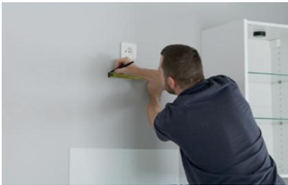
► **Per farlo**, tracciare una linea verticale con una livella a bolla d'aria dal centro della base della cappa al soffitto. Disegnate i punti di fissaggio della cappa, seguendo le istruzioni.
