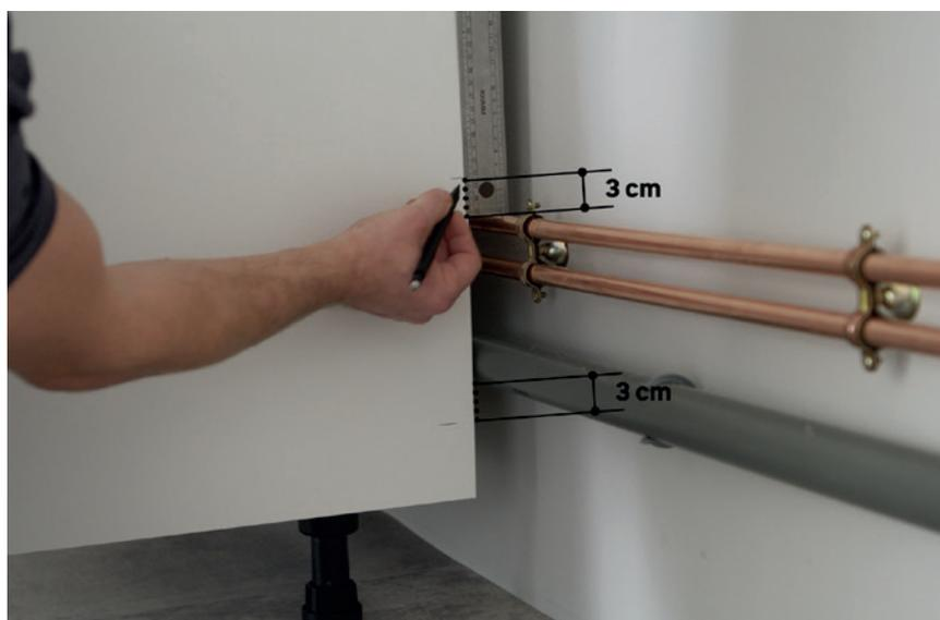
► **Posizionare il mobile**, poi riportare la posizione dei tubi con uno scarto di 3 cm in alto e in basso. Procedere allo stesso modo sull'altro lato del mobile e tracciare la linea di taglio.
