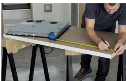
► **Controllare le dimensioni dell'apertura secondo** le istruzioni della piastra di cottura e la sua posizione in base al contorno interno già disegnato sul piano di lavoro.
