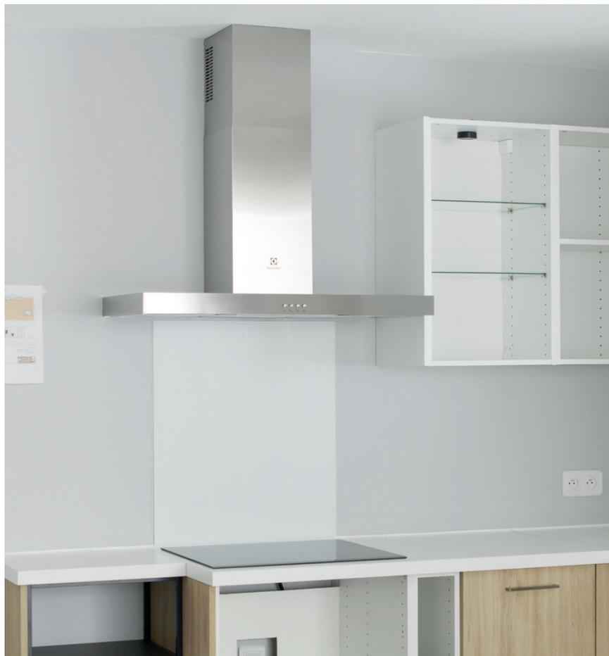
► **Rivestire la cappa** con un camino telescopico per nasconderla e lasciarla accessibile in caso di necessità. Concludere l'installazione secondo le istruzioni.
