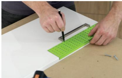
► **La posizione della maniglia è misurata dalla parte bassa dell'anta**. Quindi, utilizzando la dima di foratura per la maniglia, si segna con precisione la posizione delle estremità della maniglia.
