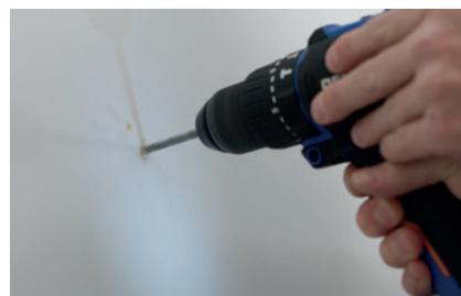
► **Rimuovere la struttura** e forare i fissaggi del diametro appropriato per la parete.
