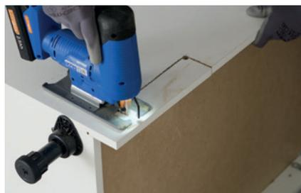
► **Forare ai due angoli interni della traccia con una punta da 10-12 mm**, per permettere il taglio con il seghetto alternativo. Ripetere l'operazione dall'altro lato.
