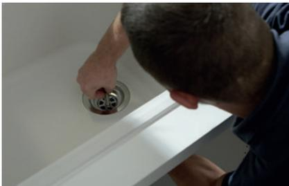
► **Prima di tutto**, chiudete l'acqua! Dopo potete chiamare un idraulico professionista per effettuare i collegamenti o eseguire il lavoro da soli collegando i flessibili, l'uscita del sifone al tubo di scarico delle acque reflue.
