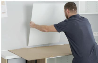
▶ **Proteggere** il piano cottura e il piano di lavoro con un grande pezzo di cartone. Verificare che la base della cappa si adatti perfettamente alle misure.
