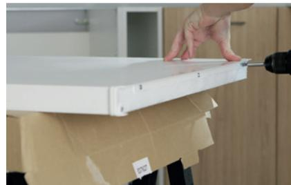
► **Posizionare il profilo** di collegamento e fissarlo con viti per legno.
