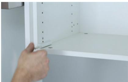
► **Regolare** il terminale ruotandolo per adattare la lunghezza, se necessario.
