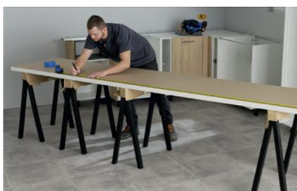
► **Posizionate il piano** di lavoro capovolto sui cavalletti in modo che il bordo visibile sia rivolto verso di voi. Trasferite le misure e tracciate una linea retta lungo la larghezza.
