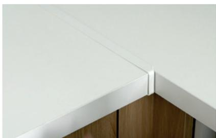
► **Applicate del sigillante** siliconico sul bordo dell'altro piano. Posizionare il piano di lavoro sul mobile. Premere il lato incollato contro il profilo di collegamento.
