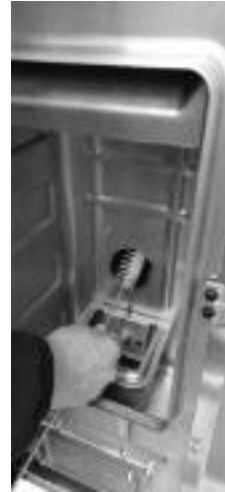
Fig. 40 - Limpieza con escobilla
