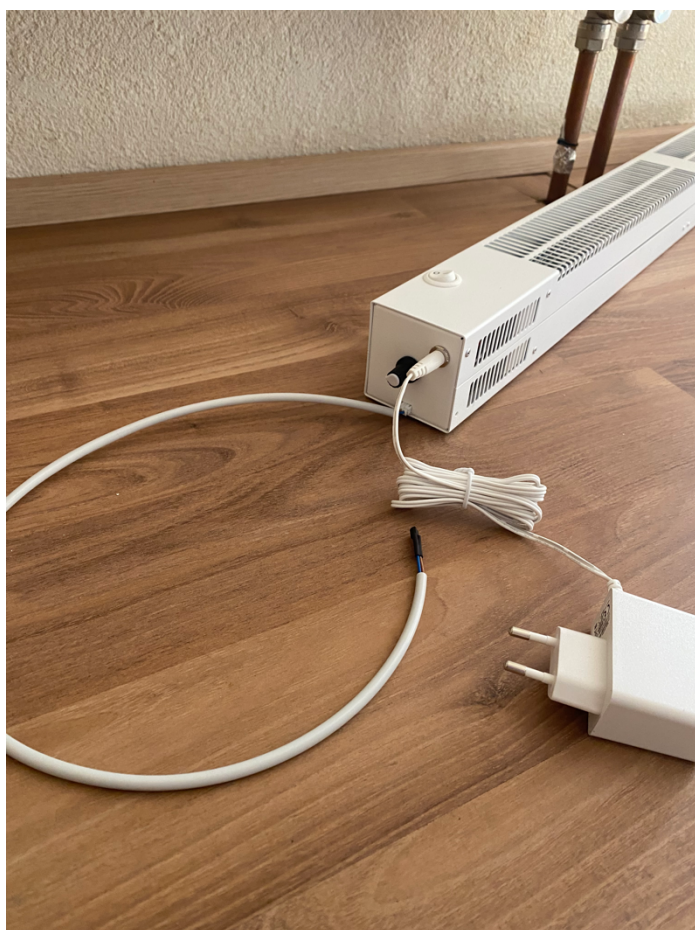
Rys. 1 Grzejnik s adapterem i czujnikiem temperatury
