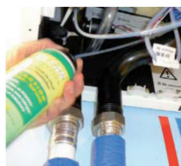
corps de chauffe
