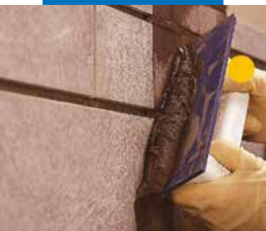
Autre exemple d'application d'Ultracolor Plus à la spatule en caoutchouc en mur
