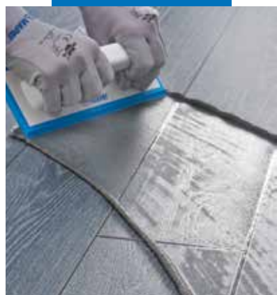
Application d' Ultracolor Plus à la spatule caoutchouc sur carreaux de grès cérâme porcelainé effet bois
