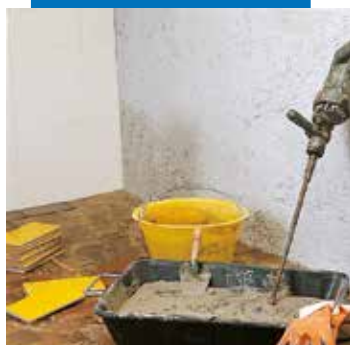
Mortier colle gâché au malaxeur électrique
