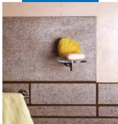
carreaux de grès cérâme porcelainé jointoyés avec Ultracolor Plus
