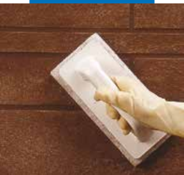
Nettoyage des joints en sol avec le scotch Brite (sur produit partiellement durci)
