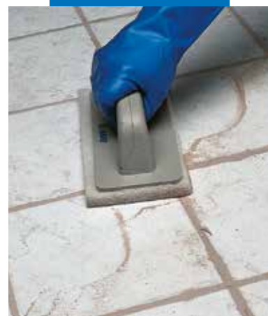
Finition au Scotch-Brite®
