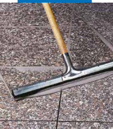
Jointoiement de granit à la raclette
