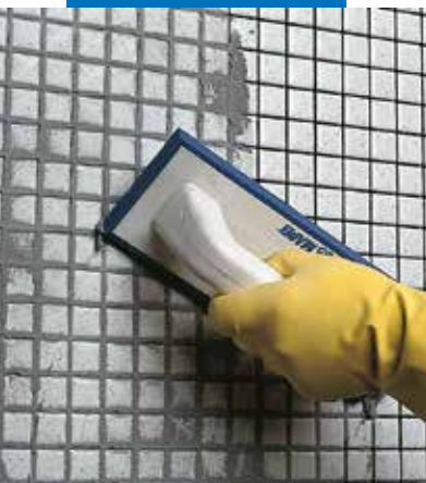
Remplissage des joints entre carreaux de pâte de verre à la spatule, dans une salle de bains
