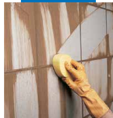
Finition des joints en mur à l'éponge
