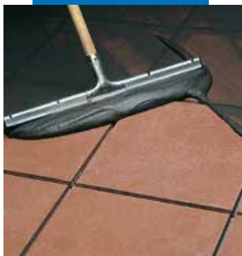
Jointoiment de terre cuite en sol à l'aide d'une raclette
