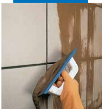
Jointoiment en façade à l'aide d'une spatule
