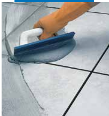
Jointoiment de carrelage en sol à l'aide d'une spatule caoutchouc
