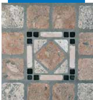
Exemple de jointoiement entre éléments de pierre naturelle vieillie
