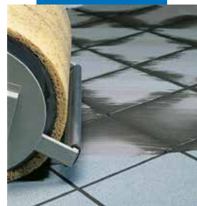
Finition des joints en sol à la machine
