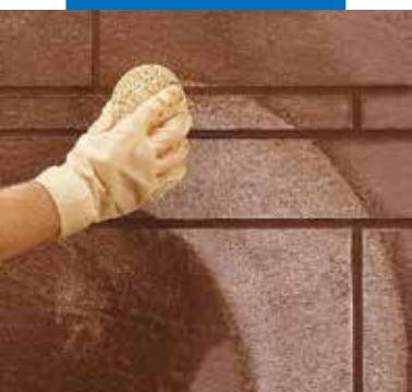
Nettoyage et finition des joints à l'éponge
