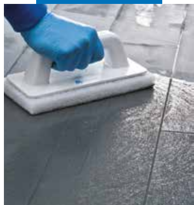
Nettoyage des joints au Scotch-Brite (sur produit partiellement durci)
