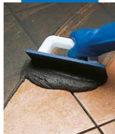
Jointoiement entre carreaux de grès émaillé, à la spatule
