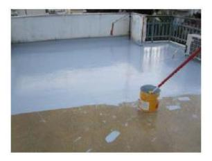
Aplique la primera capa con brocha o rodillo. Mida el área para sacar el volumen correcto del material. Por ejemplo, si se usa 1 l/m² por capa cada lata de 15 l cubrirá 15 m². Delimite el área de la cubierta y asegúrese de que se emplea la cantidad necesaria de material dentro de esa área delimitada.
