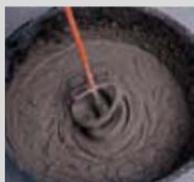
Amasar **weber.col panda** con 6,5 – 7,5 litros de agua limpia por saco de 25 kg, manualmente o con un batidor eléctrico lento (500 rpm), hasta obtener una masa homogénea y exenta de grumos.
