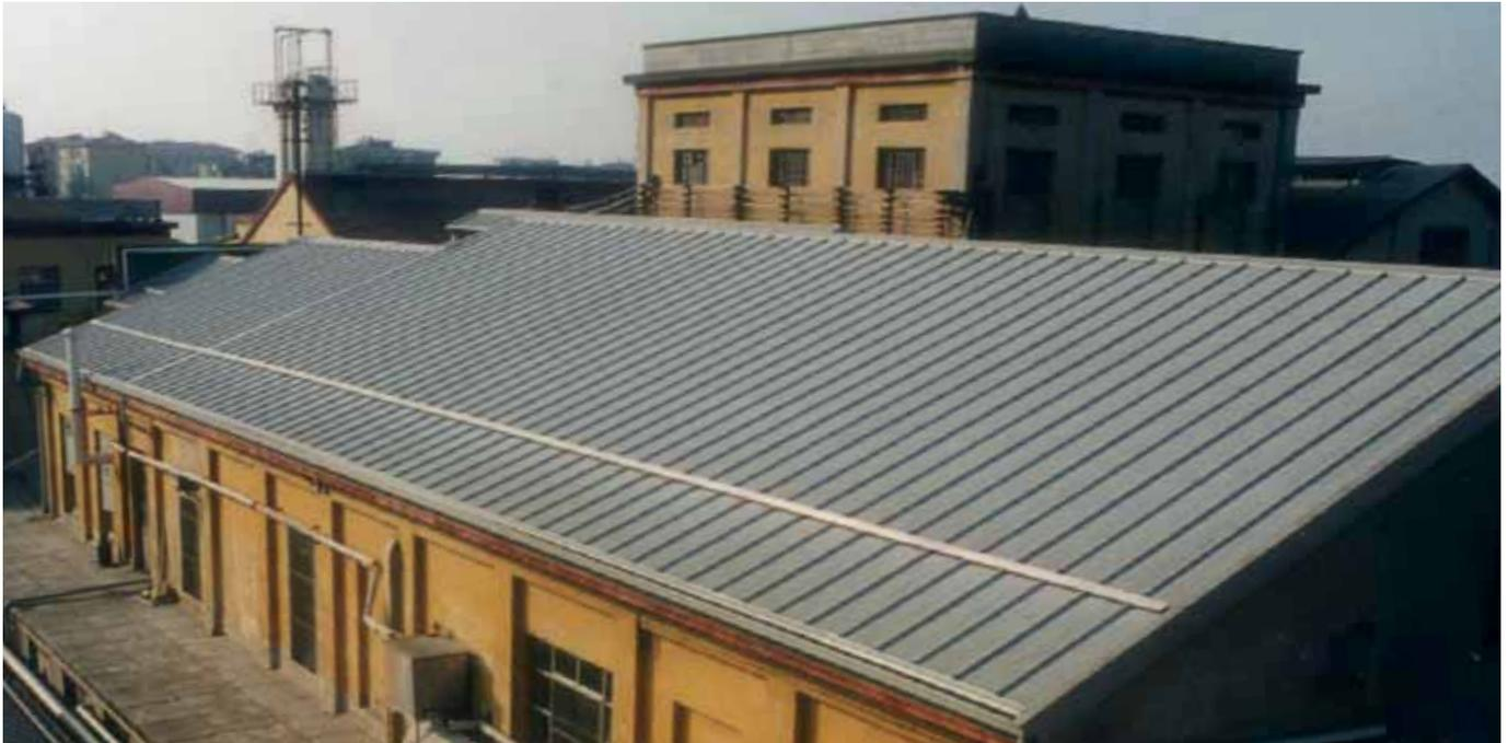
Panel sándwich de doble revestimiento metálico, para cubiertas con pendiente no inferior al 7%, aislado en poliuretano, con lámina exterior perfilada de 3 grecas. La fijación es a vista con grapas y guarniciones.
