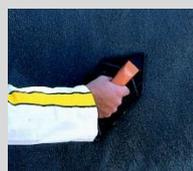
El acabado se puede realizar con frásas o esponja, según la textura deseada. Para un correcto curado, es muy importante mojar la superficie impermeabilizada 24 horas después de la aplicación, y repetir la operación durante 4 días.
