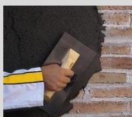
Sobre el soporte húmedo. Extender el producto a llana y reglearlo, siendo el espesor final de 10 mm, como mínimo, en cualquier punto. Para aplicaciones superiores de 10 mm de espesor, aplicar capas sucesivas de 5 a 10 mm.
