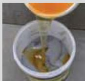
Mezclar los dos componentes de **weber.epox easy** en su totalidad con un batidor eléctrico lento (500 rpm) hasta obtener una masa suave y homogénea.
