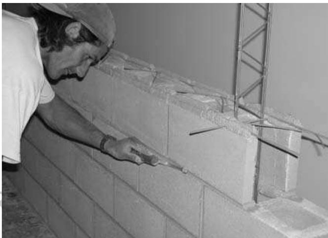
En fábricas para revestir se recomienda dejar la junta ligeramente rehundida para mejorar la adherencia del revestimiento.
