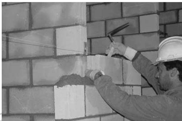
Se aplicará mortero sobre los salientes de la testa del bloque, presionándolo para evitar que se caiga al transportarlo para su colocación en la hilada, y en cantidad suficiente para garantizar que la llaga quede rellena.
