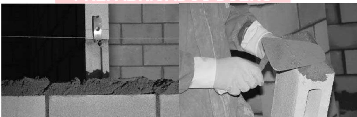
No se debe intentar alinear un bloque después de haber colocado otra hilada sobre él, ya que se formaría una discontinuidad de la unión bloque-mortero en las juntas contiguas.
