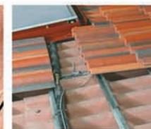
COLOCACIÓN DE LAS TEJAS SOBRE LAS PLACAS MEDIANTE RASTRELES
