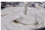
Amasar el producto con 7-9 litros de agua limpia por saco de 25 kg con un batidor eléctrico lento (500 rpm) hasta obtener una masa homogénea y exenta de grumos. Dejar reposar la mezcla unos 2 minutos y realizar un ligero reamasado.
