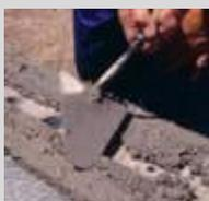
Como mortero de montaje de bloques cerámicos o de hormigón, colocar con paleta un espesor regular y continuo de pasta sobre el bloque.
