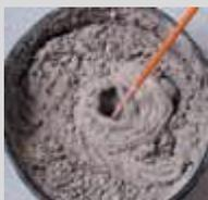
Amasar **weber CMK** con 3,5 - 4,5 litros de agua limpia por saco manual o mecánicamente, hasta conseguir una masa homogénea. No se puede proyectar.
