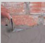
Para su aplicación como enfoscado tradicional, extenderlo sobre el cerramiento para proceder después a fratarlo.
