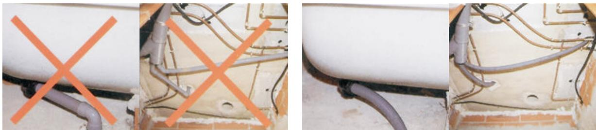
Se ha comprobado a través de un estudio realizado a varias instalaciones, que el ahorro entre una instalación acabada con P.V.C. rígido e HIDROTUBO Espiroflex, supone un 15% sobre el coste. Al ir en bobinas de 50 metros, se evitan las constantes uniones.
